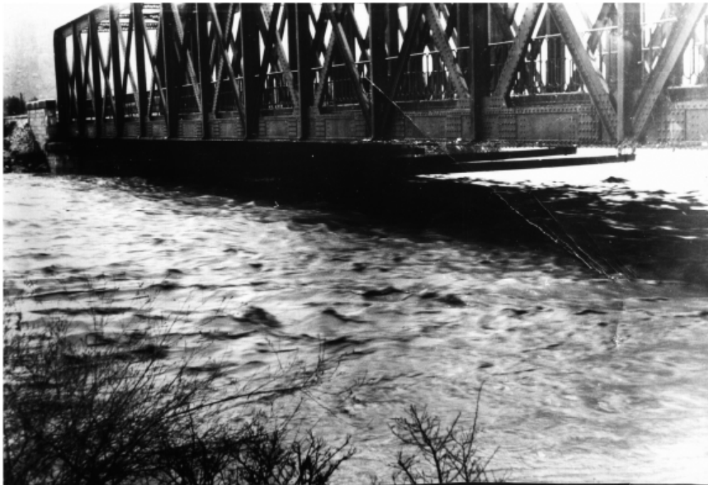
Fig. 48. Crue de juin 1957 au pont noir (amont du confluent Guil / Durance)
